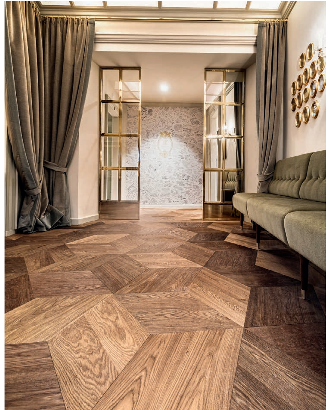
Es kommt auf den Standpunkt an: Aufgrund des Verlegemusters des Tafelbodens und der farblichen Nuancen der rautenförmigen Elemente entstehen bei Veränderungen des Blickwinkels und Lichteinfalls aus Sternen dreidimensional wirkende Würfel: ein optischer Effekt, den man auch von alten, hell-dunklen Steinböden in Kirchen und Palazzi kennt.
